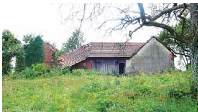
Hiša pred obnovo (foto: P. Kogler)
